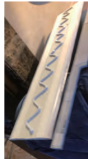
※推奨ボンド：アイカ エコボンド変成シリコン樹脂系 SE-1 仮留テープ：アイカ ZK-31.32
