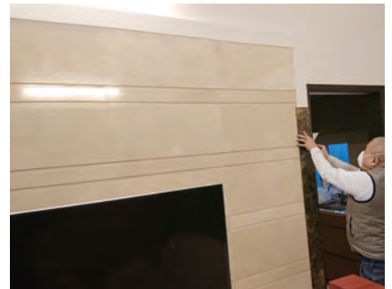
※推奨ボンド：アイカ エコボンド変成シリコン樹脂系 SE-1 仮留テープ：アイカ ZK-31.32
